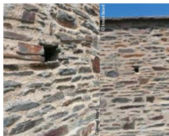
Exemples de restauration de mur avec insertion de gîte potentiel
